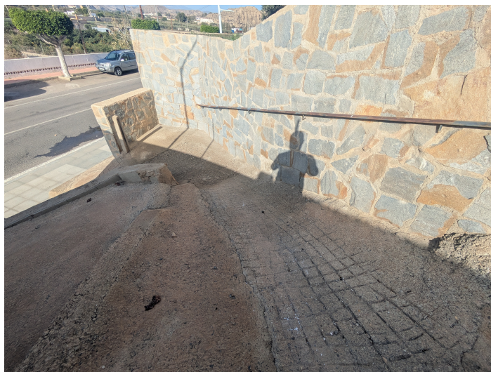
Imagen Calle Tramo Final
