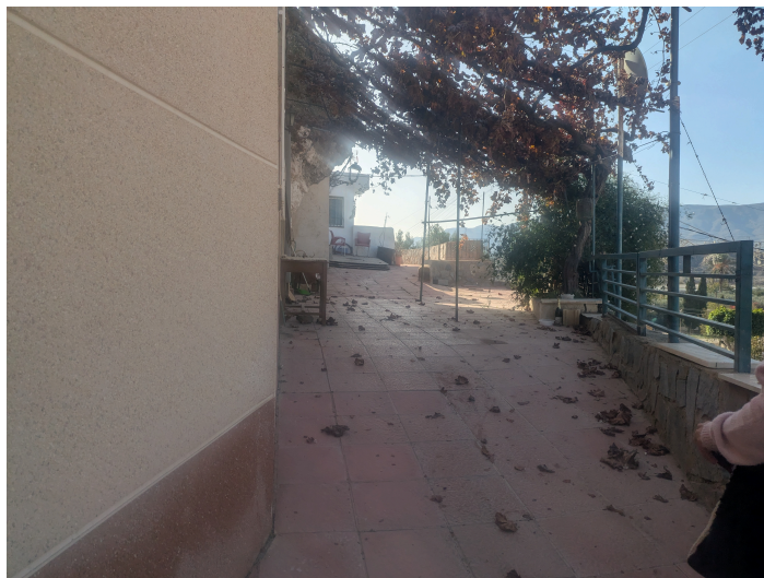
Imagen Calle subida desde Calle Toril
