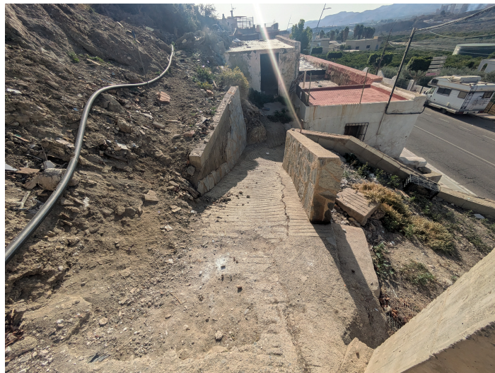
Imagen Calle Tramo Final
